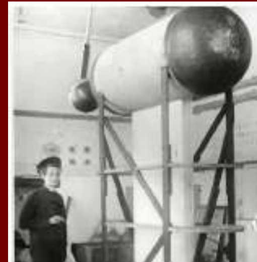
К.Д. Синельников в лабораторії ядерної фізики в УФТИ разом з горизонтальним прискорювачем Ван де Граафа. 1930-е роки
