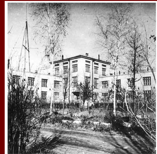
Главный корпус УФТИ
