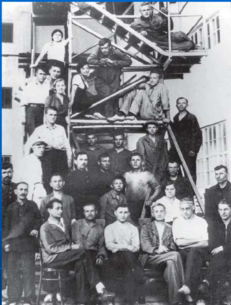
Монтаж електростатичного генератора. У першому ряду сидить К.Д. Синельников. На стропилах сидить А.К. Вальтер.
